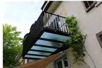
Beispiel: stützloser Balkon an denkmalgeschütztem Altbau
